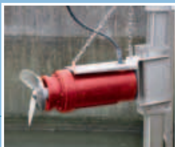
Fasi di installazione di miscelatore sommerso tipo MX-gi. Installation stages of a submersible mixer type MX-gi.
